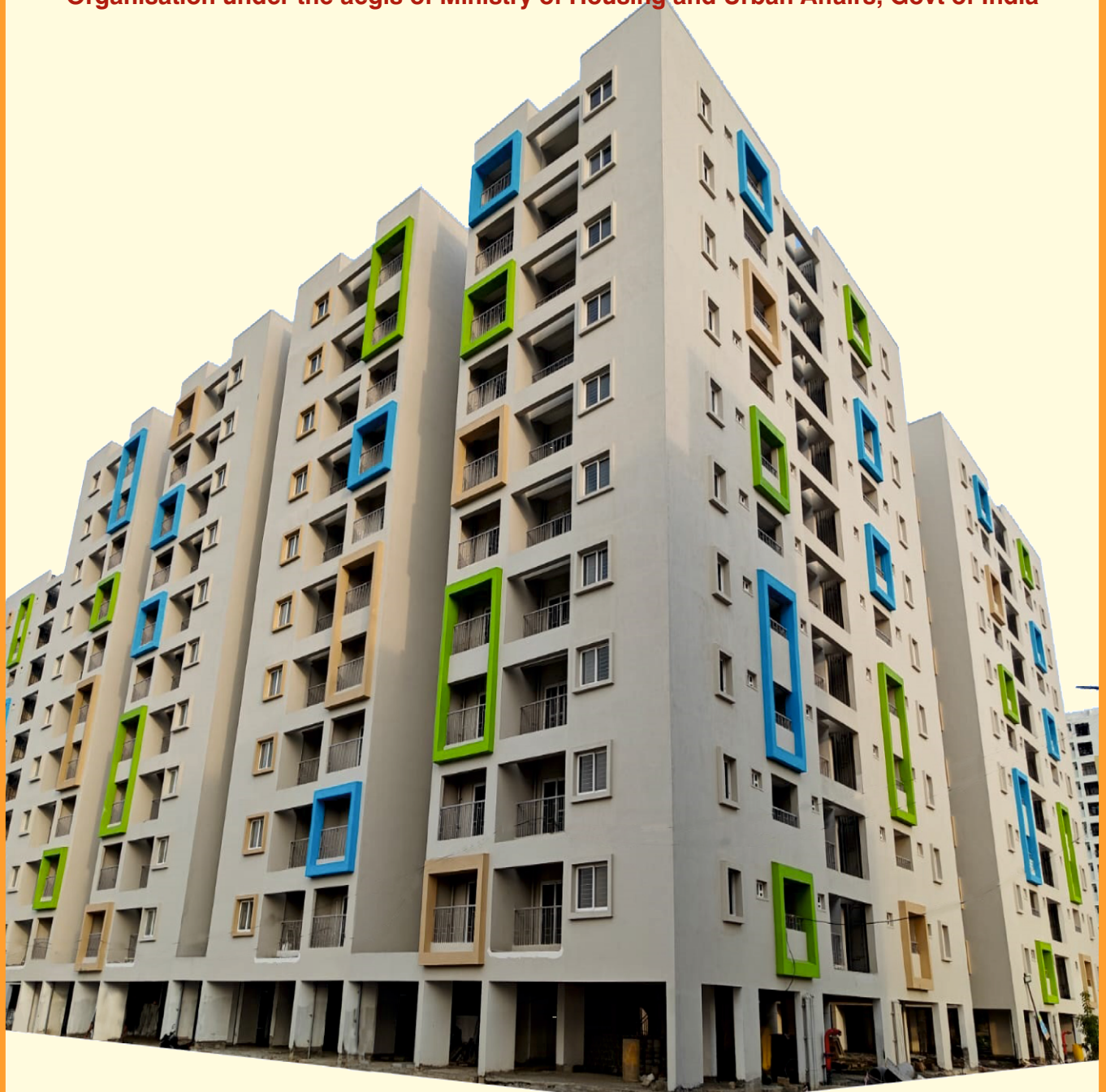
Chennai Phase-III Actual Image D3 Block
